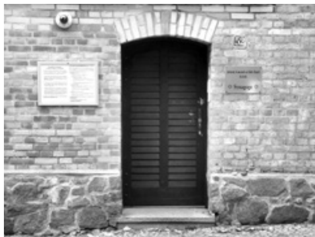
Tür der Synagoge in Halle/Saale, auf die am 9. Oktober 2019 ein Anschlag verübt wurde.
